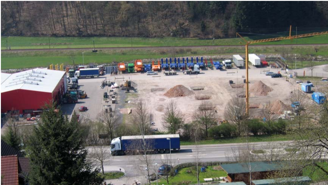
Blick auf die Baustelle der neuen Montagehalle – Stand 21.04.2006
